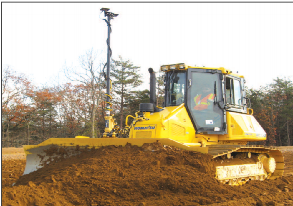
2.1.2 pav. Buldozerio Komatsu D51EX panaudojimas atodangos darbuose
